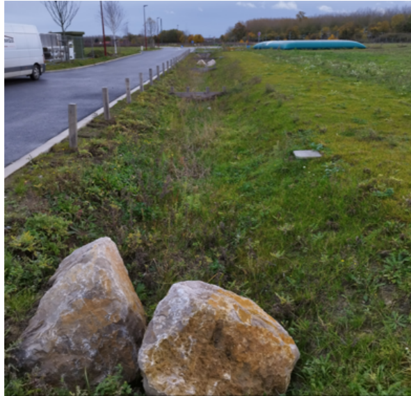
Figuur 10: Voorbeeld van een wadi met regelmatige onderbrekingen langs een weg in de buurt van Doornik (foto genomen door ARIES, 2022)
