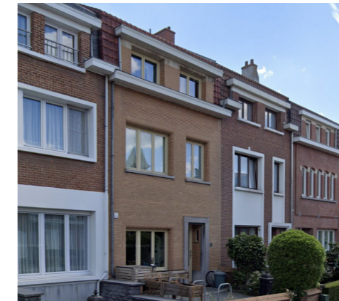
Maisons R+2+T Avenue Crokaert
