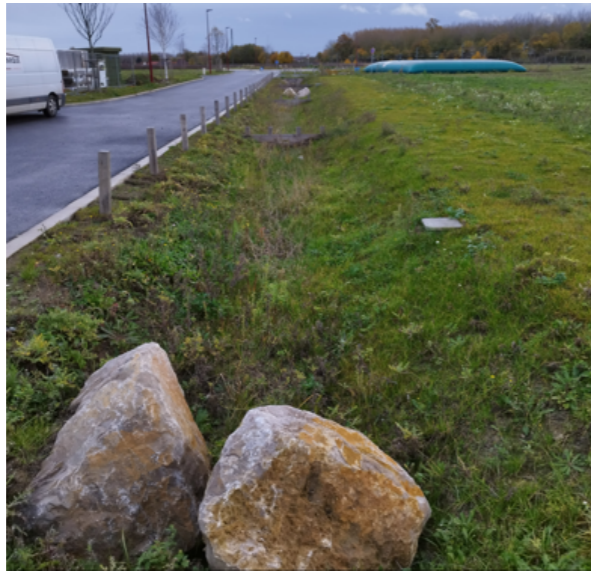
Figure 10 : Exemple de noue en long de voirie avec redents réguliers près de Tournai (photo prise par ARIES, 2022)
