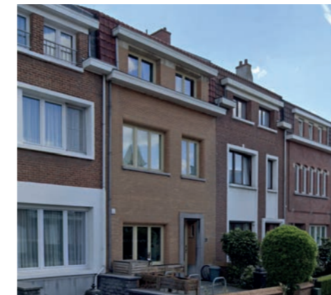
Maisons R+2+T Avenue Crokaert
